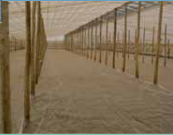
Sellado con plástico en invernaderos comerciales
